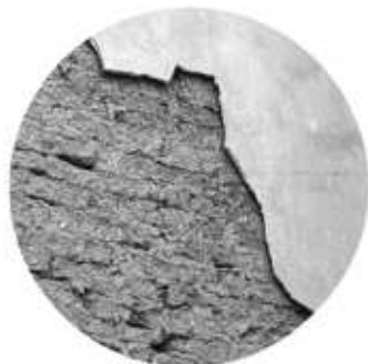
4. Αποκατάσταση Επίχρησματος Τοιχοποιίας
