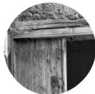
5. Αποκατάσταση Ξύλινων Στοιχείων
